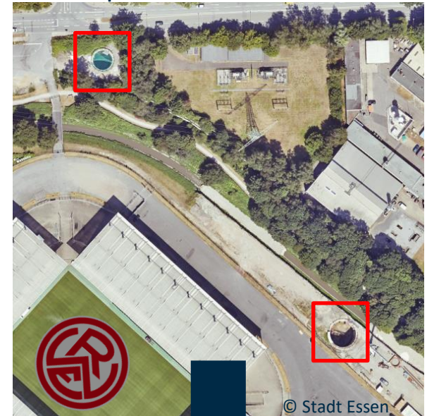
Exemplarisch: Luftbild mit Baustellen
